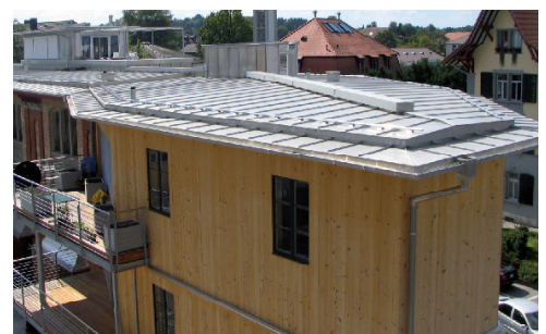
Alte Kohlenhandlung, Langenthal - Svizzera. Architetti : Blum & Rossenbacher Realizzata con il tipo UGINOX FTE
