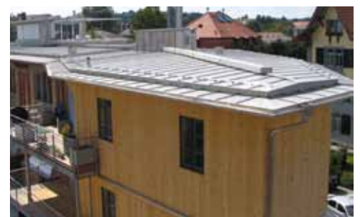
Alte Kohlenhandlung, Langenthal - Schweiz Architekten: Blum & Rossenbacher Ausgeführt in UGINOX FTE
